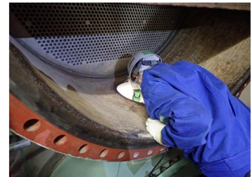
1次冷却系熱交換器の開放点検
